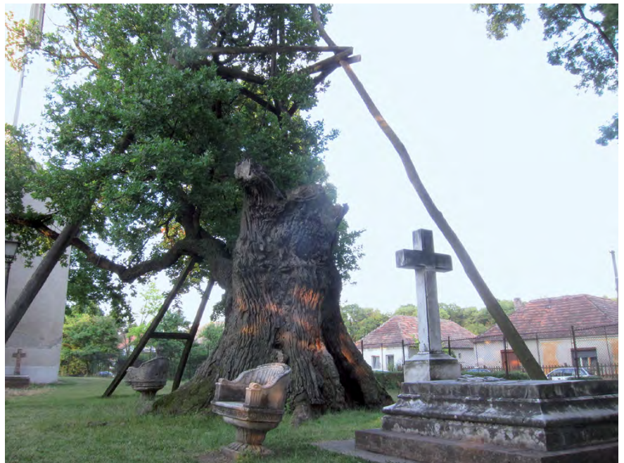
Abb. 27: Statische Sicherung zum Erhalt des Baumes
